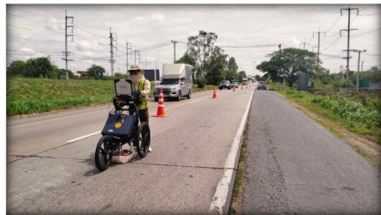
การสำรวจโพรงใต้ผิวทางจราจรด้วยเครื่อง GPR ทางหลวงหมายเลข 347
